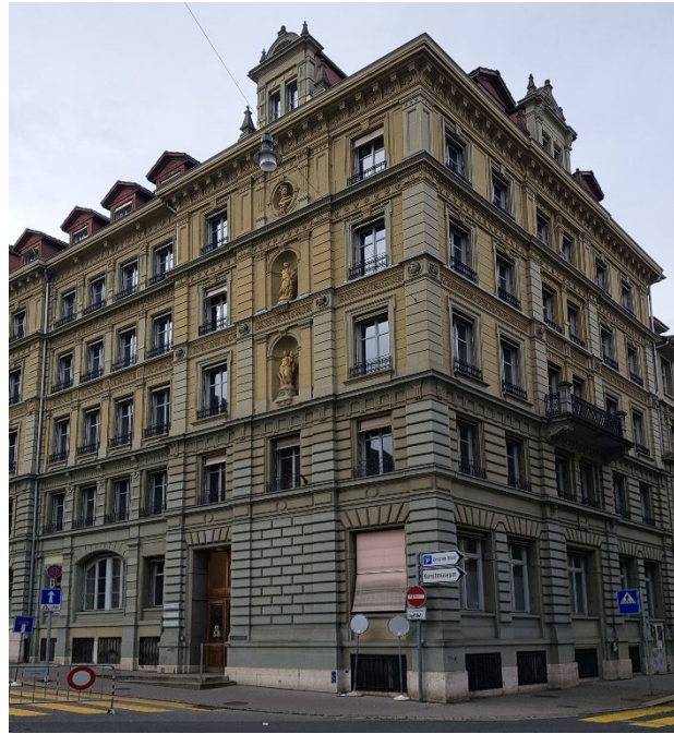
An der Predigergasse 10 ist bis zum heutigen Tag das «Amt für Erwachsenen- und Kinderschutz» der Stadt Bern einquartiert, die frühere Vormundschaftsbehörde. Hier wurden und werden Armut und soziale Marginalisierung verwaltet (Foto DS).
